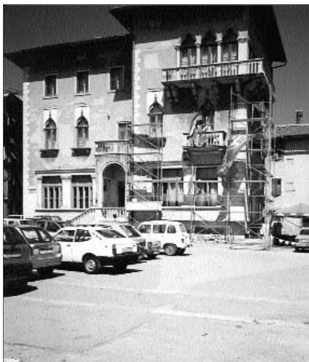
La palazzina del Municipio, in fase di restauro. Il giorno della sistemazione delle impalcature è successo un putiferio. Tondini, assi e operai hanno seminato il panico tra la nutrita colonia di rondini che nidifica sotto il tetto e sotto il balcone centrale. Allo stridere degli uccelli ha risposto la voce preoccupata dei dignanesi. Non si sa come andrà a finire. Certo è che i bumbari non vogliono perdere le loro rondini.
