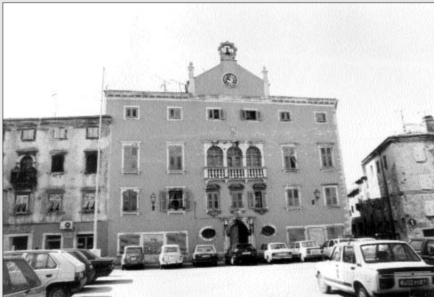
Palazzo Bradamante, futura sede della CI di Dignano
