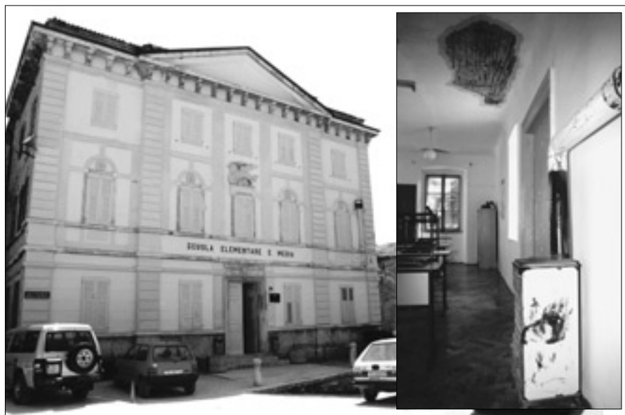
La sede centrale della Scuola Elementare Italiana di Buie. Gli interni della scuola: una delle aule, peraltro ancora riscaldata da una anacronistica stufa a legna, con vistosi segni di cedimenti sul soffitto.
