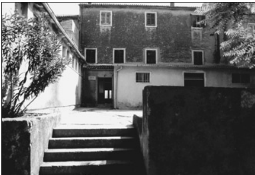
La parte retrostante della Comunità degli Italiani cui si riferisce la prima fase dei lavori di ricostruzione del sodalizio. A sinistra della foto l'ex forno che sarà ampliato di un piano.
